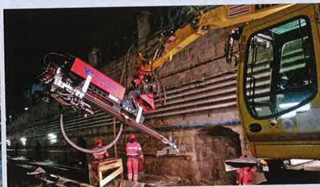
Auch zwei Anbaubohrlafetten AB3600 der Firma Wimmer, montiert auf zwei Zwei-Wege-Baggern, kommen zum Einsatz.
